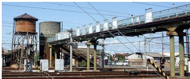
目煉瓦製の給水塔は大正2年頃建築、二基目鉄骨製の給水塔は昭和初期の建築といわれています。SLがそこらじゅうを走っていた時代は各地に給水塔がありましたが、今は全国的にも少ないのではないのでしょうか。また、多度津駅のように異なる年代の給水塔が当時のまま残されているのは珍しいと思います。
