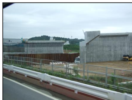
[図 27]建設中の橋
