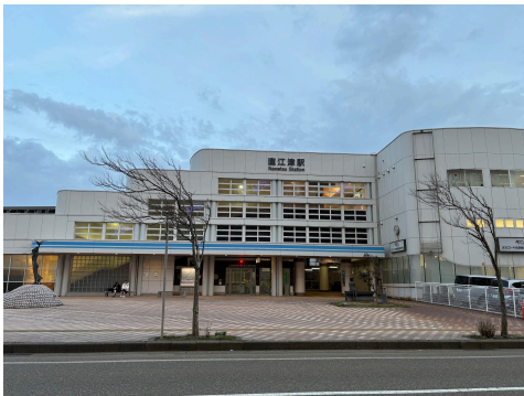
直江津駅の駅舎
