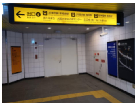
中之島駅の地下通路 この先になにわ筋線の駅ができる予定
